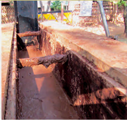
POURED EARTH WALL
